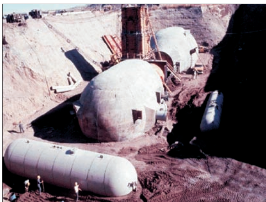
Строительная площадка ПУП МБР
